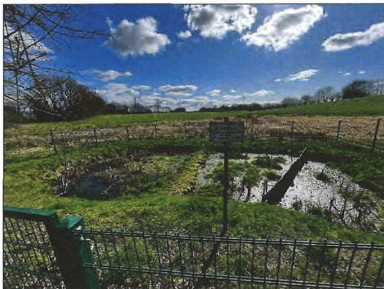
Abbildung 4: Regenrückhaltebecken (Foto: ALSE 03.04.2023)
